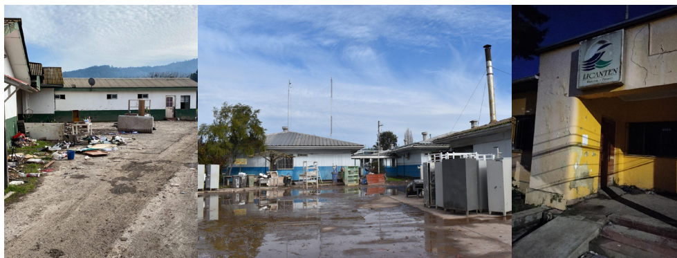
Figura 17. Afectación de infraestructura crítica en Licantén.
