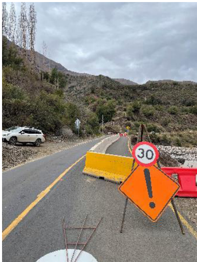
a. Terraplén socavado por flujo lateral b. Solo una calzada habilitada en km 49.5
