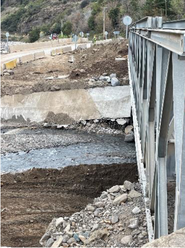
a. Terraplenes de acceso puente Mecano San Alfonso
