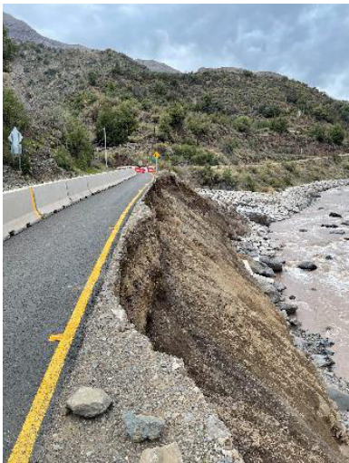
a. Terraplén socavado por flujo lateral b. Solo una calzada habilitada en km 49.5
