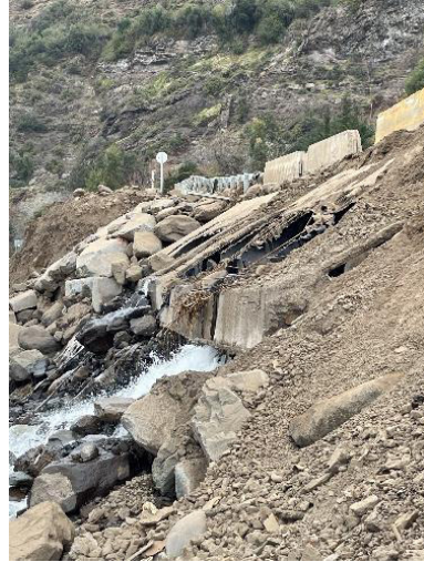
b. Zona bajo el paso habilitado para camiones pesados en puente Mecano San Alfonso
